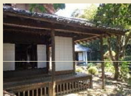
座敷廻りの土庇
