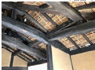
主屋、土間上部梁組
